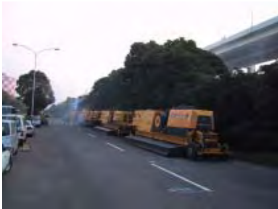
写真－3. 2 施工時の煙（編成前方から）
