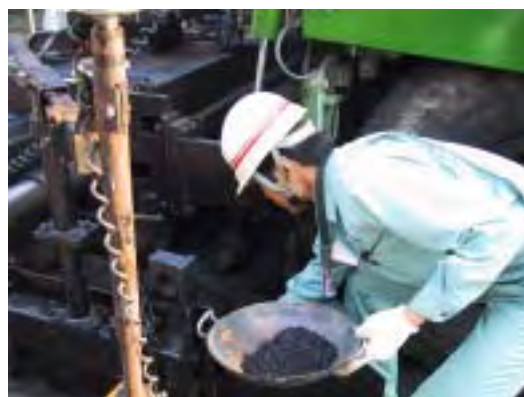
写真－3. 9 再生混合物の採取
