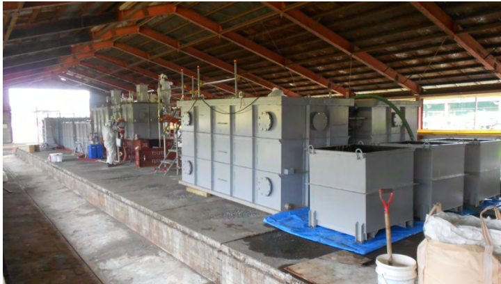
処理水槽の設置
