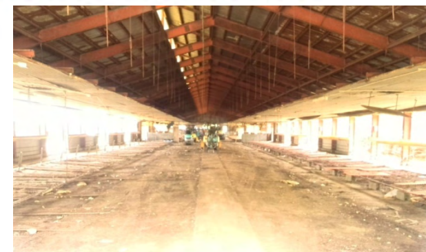
分娩豚舎2の内部に設置
