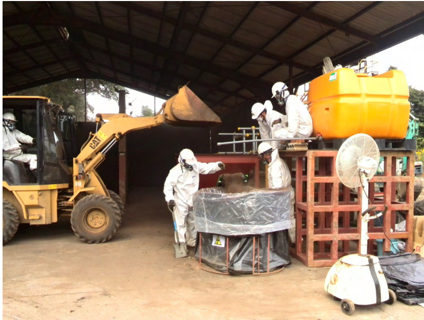
二酸化塩素除菌剤（クローツ）散布と フレコンバックへの封入
