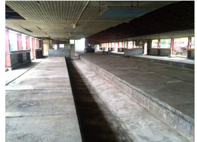
豚舎内部材撤去完了
